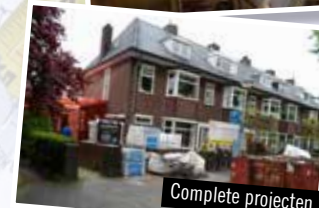
Dakkapel maken + plaatsen
