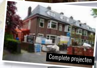
Dakkapel maken + plaatsen
