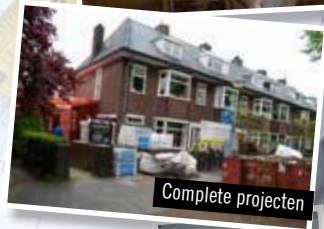
Dakkapel maken + plaatsen
