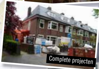
Dakkapel maken + plaatsen
