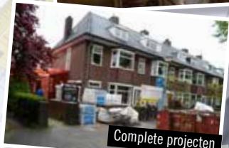
Dakkapel maken + plaatsen
