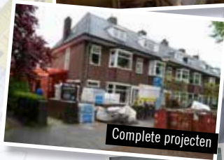
Dakkapel maken + plaatsen
