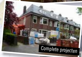
Dakkapel maken + plaatsen
