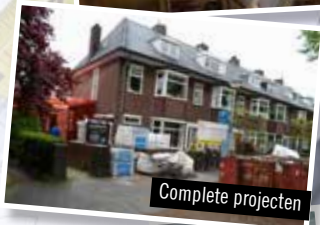
Dakkapel maken + plaatsen
