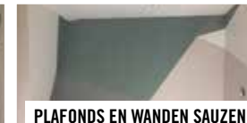
PLAFONDS EN WANDEN SAUZEN
