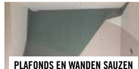
PLAFONDS EN WANDEN SAUZEN
